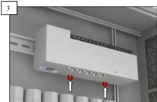
3 Fäst basstationen säkert med låsmekanismen på DIN-skenan.
