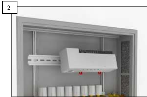
2 Placera basstationen något lutad på DIN-skenan och lås den.
